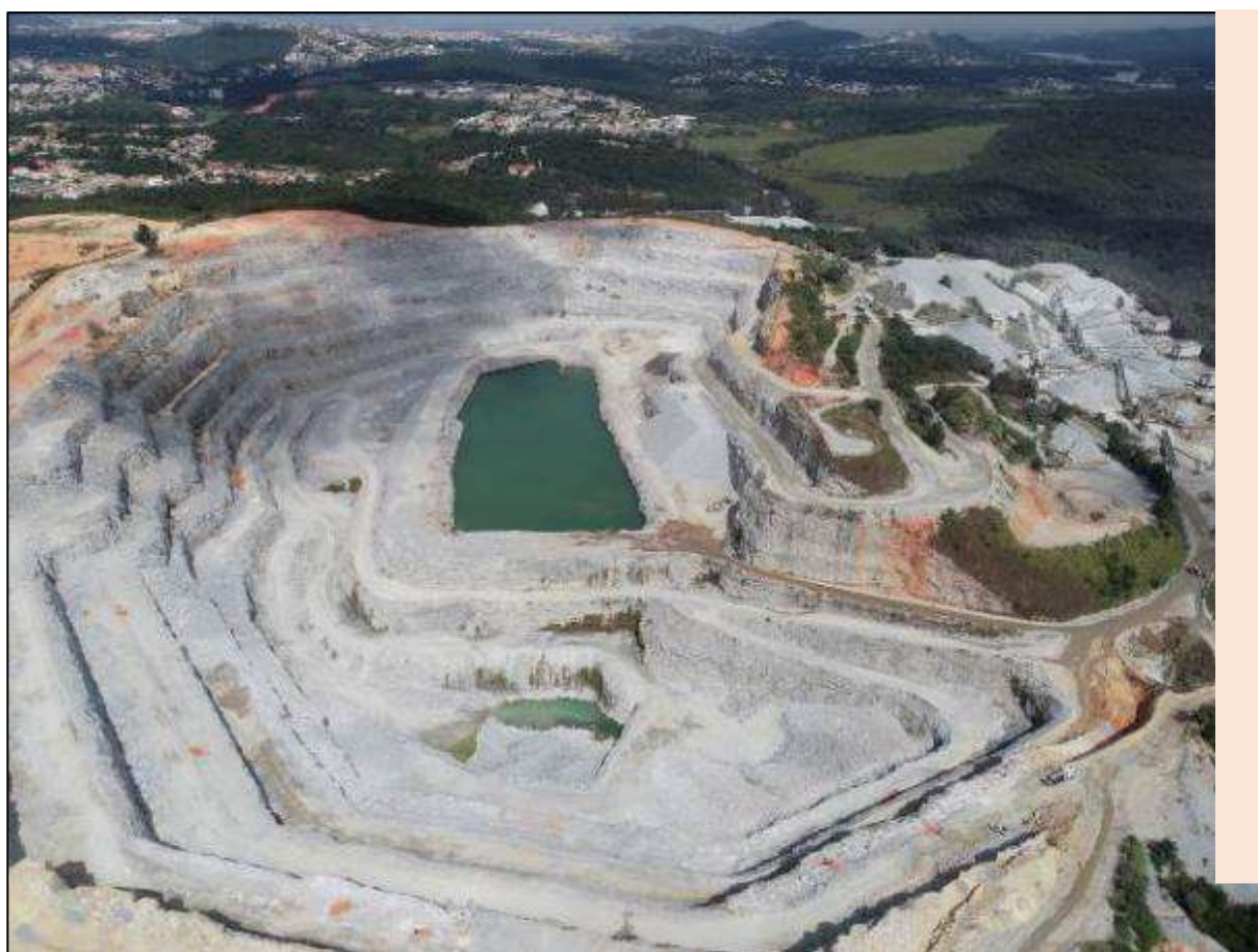
Bacia de proteção final da drenagem de águas pluviais incidentes na cava.
