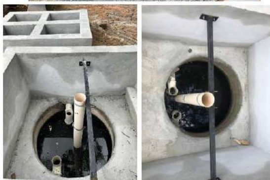
Fossa séptica existente.
